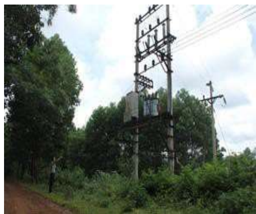
Công trình 35kV – Quảng Nam
