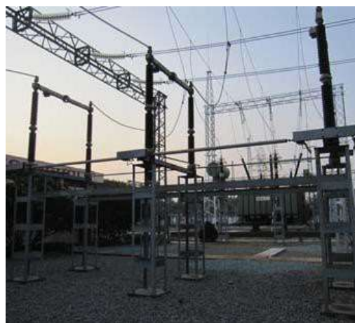
Dự án 500kv – Hà Tĩnh
